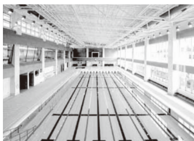
屋内温水プール
