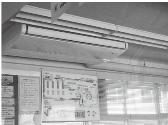
▲ 設置されたエアコン
