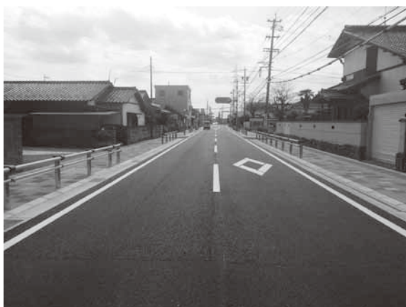
▲ 工事後のグリーン通り
