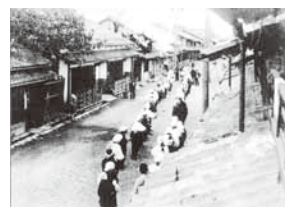
本町で行われた消火訓練バケツリレー
