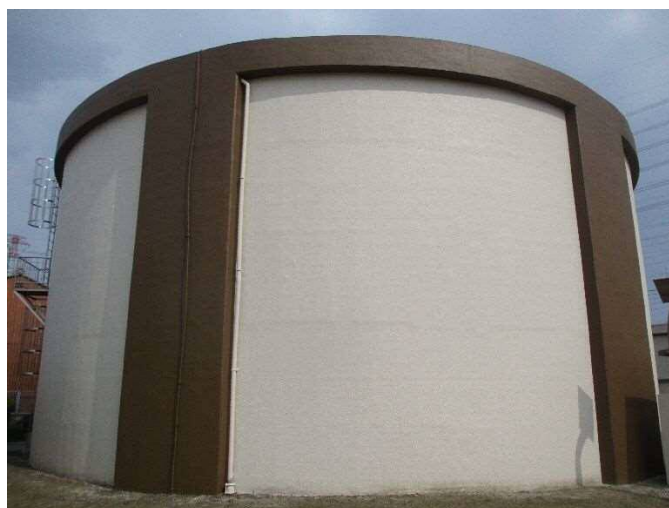
■写真 3-2 1号配水池
