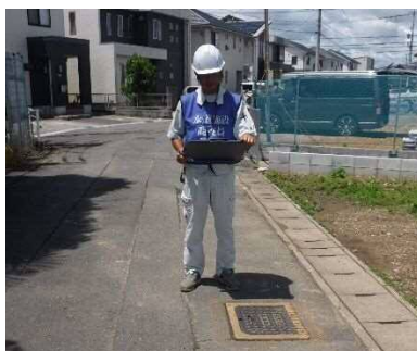
■写真 3-1 配水管漏水調査状況
