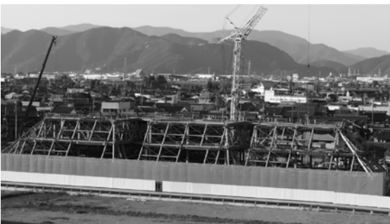
建設中の新庁舎
